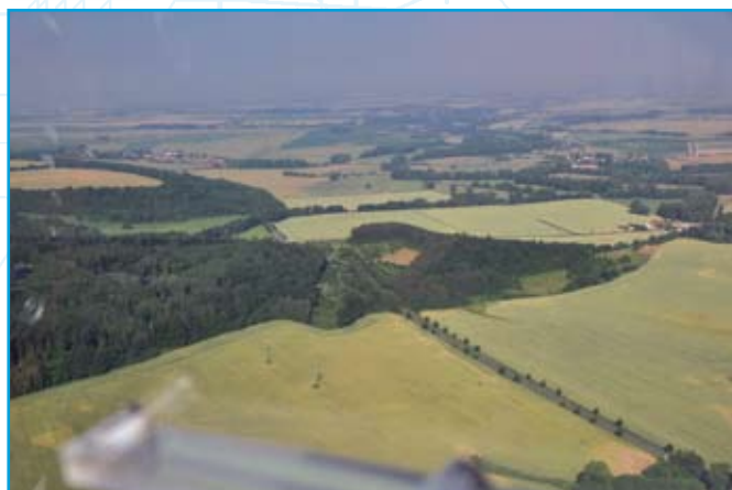
Silnice I/17 v místě tunelu Vraclav
